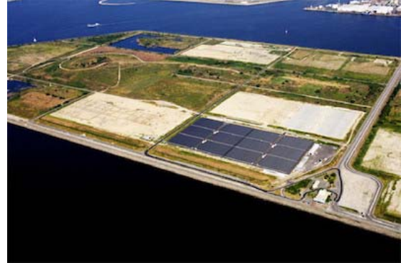
堺太陽光発電所
